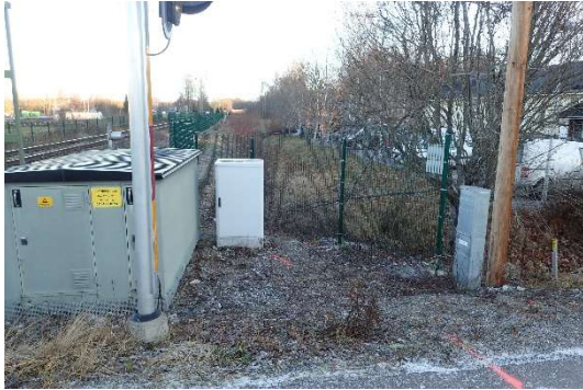
Fotografi 26. Mark öster om plankorsning Gärdesgatan. Dike avskärmar mellan järnväg och parkering inom fastigheten Sörberge 2:410.
