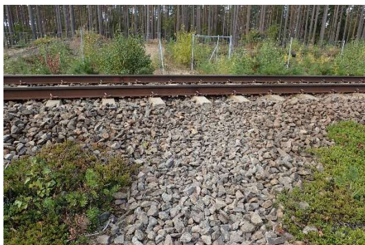
Fotografi 31. Stig över järnväg, norr om plankorsning Sandarna, i höjd med busshållplats. Öppning i staket i bakgrunden.
