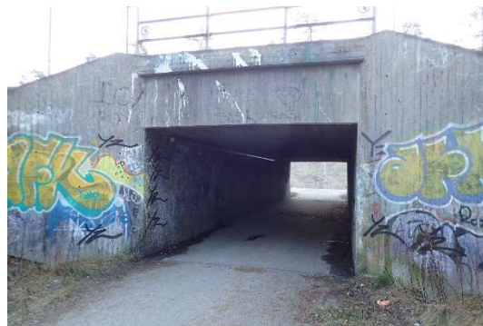
Fotografi 8. Gång- och cykelport under järnvägen, norr om plankorsning Tallvägen. Bild tagen från väster.
