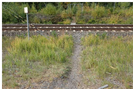
Fotografi 28. Plankorsning Svenska Trärör. Bilden visar stig av spårspring. Stängselöppning i bakgrunden.
