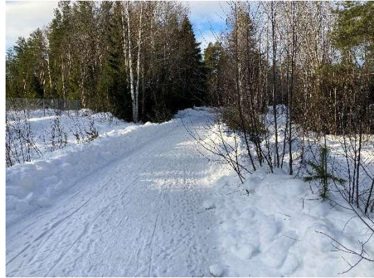
Fotografi 43. Gång och cykelbana/Gullnäs vägen, väster om järnvägen.
