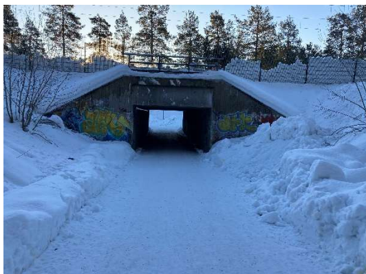
Fotografi 15. Gång- och cykelport under järnväg med koppling mot E4:an. Snöröjning genomförd
