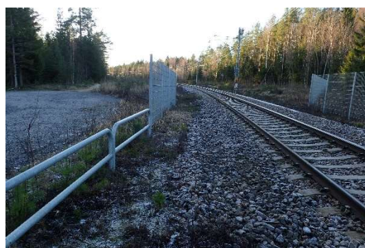
Fotografi 45 Plankorsning Stavreviken. Bilden visar hur personskyddsstängslet begränsar sikten söderut.
