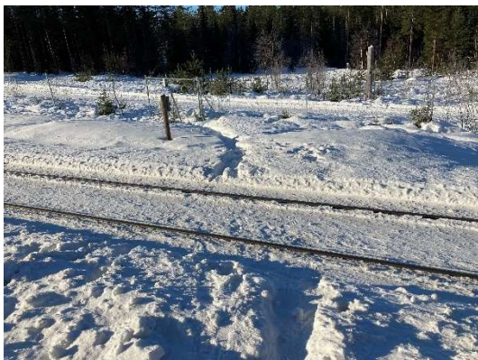
Fotografi 36. Plankorsningen Sandarna. Fotspår över spåret. I bakgrunden, en öppning i staketet.
