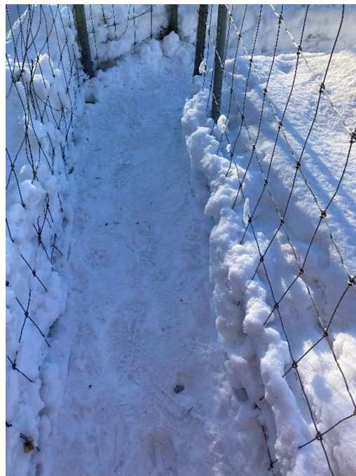
Fotografi 38. Uppskottad och upptrampad öppning i viltstängsel intill väg 331. .
