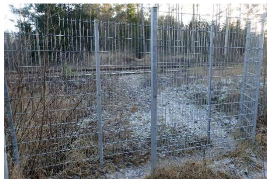
Fotografi 30. Plankorsning Ljustorpsån. Stängselöppning och stig vid plankorsning.
