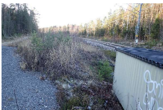
Fotografi 44. Plankorsning Stavreviken. Bilden visar teknikhus och skymmande kulle/jordhög bakom teknikhuset.
